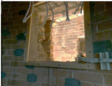
灯台内部のレンガ二重構造
